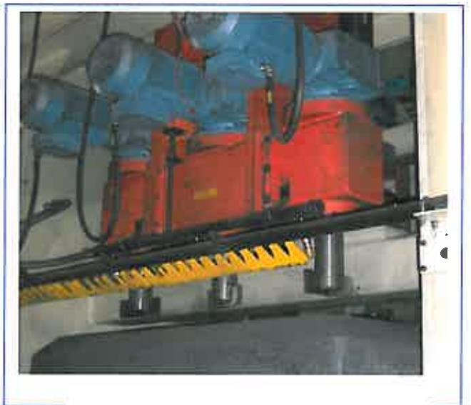
Nettoyage de trous de pilier d'anode
